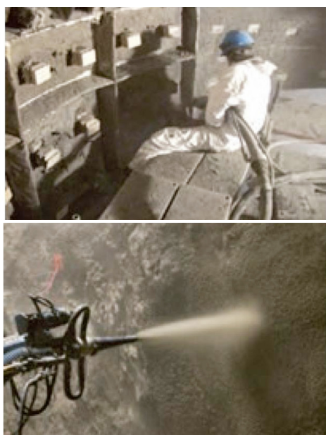
تصویر ۱۰- نصب جرم به روش پاشش
